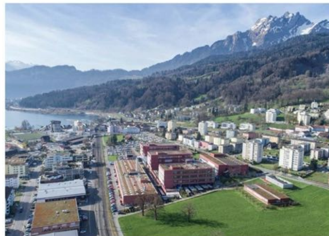
Abbildung 1: Ansicht Campus Horw von Norden Quelle: Kanton Luzern
