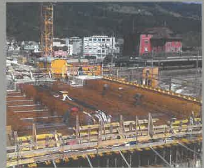
3. Betonieretappe Brückenplatte
