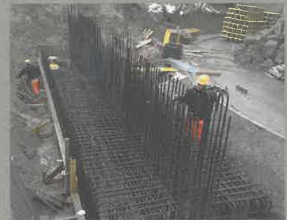
Bewehrung Fundament Brückenpfeiler
